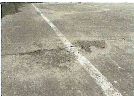
Foto 11: TORTA DEL PATIO EN MAL ESTADO POR RAJADURAS, BORDES LEVANTADOS Y SIN RECUBIERTA
